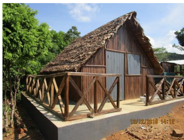
Figure 9: Local annexe du bureau à Belinta
